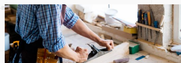
Строительные работы и ремонт помещений
